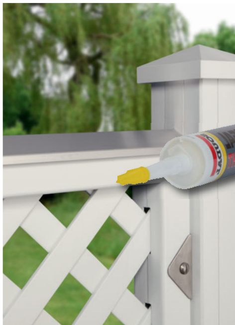
Designaufsatz Alu mit MS-Polymer-Kleber (1398) befestigen.
